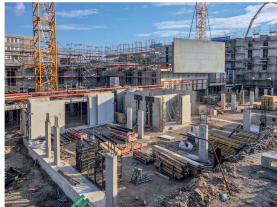
Einheben der Betonfertigteile
