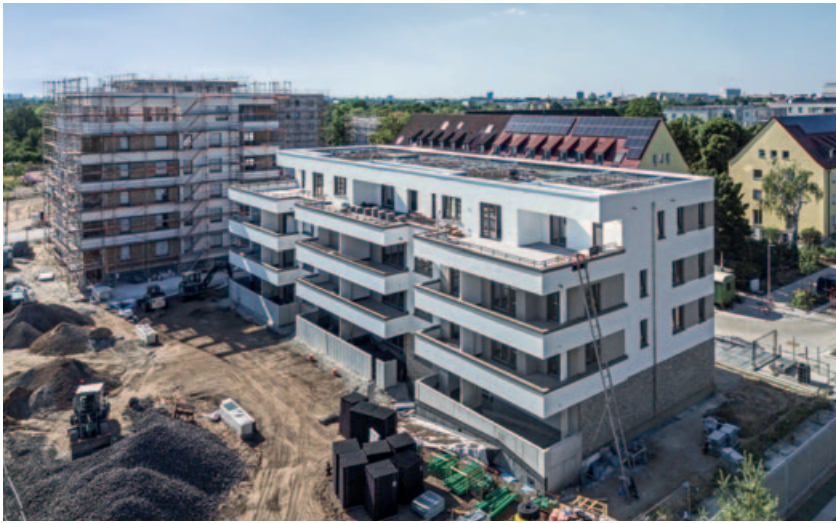
122 Wohnungen in klassisch-moderner Architektur
