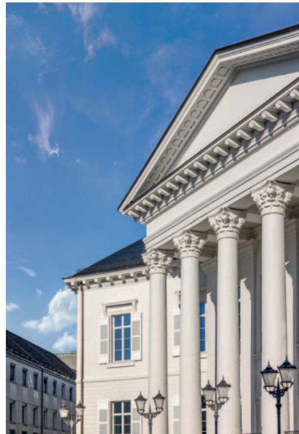
Der klassizistische Mittelbau mit dem Portikus wurde denkmalgerecht saniert
