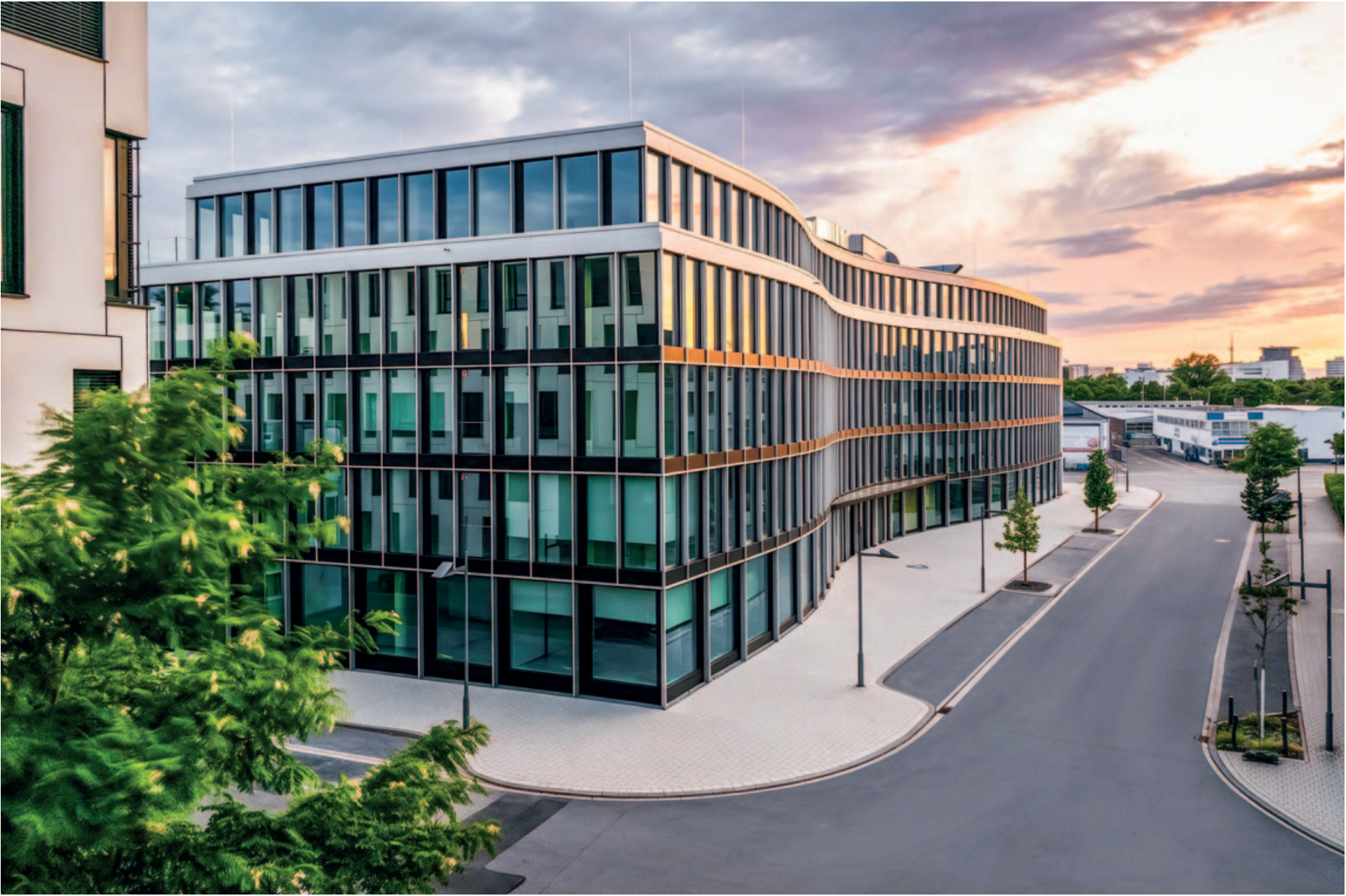
Corporate Architecture par excellence: Mit seiner dynamischen Form und Metallfassade spiegelt das Gebäude den innovativen Anspruch der ICS Group architektonisch wider
