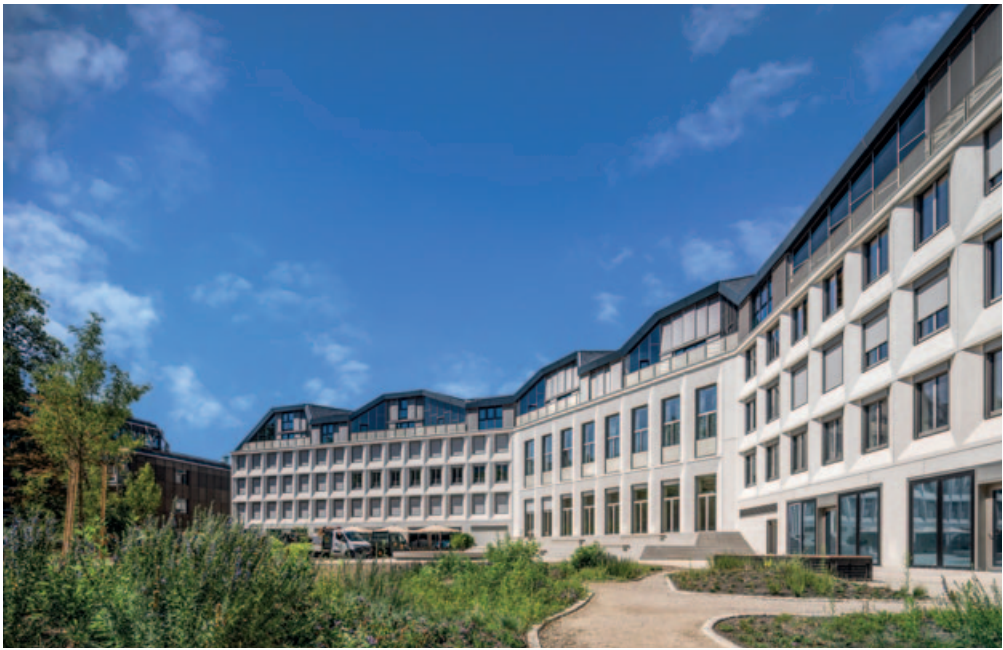
Die Fassaden der Blockinnenbebauung sind durch die reliefartige Struktur geprägt
