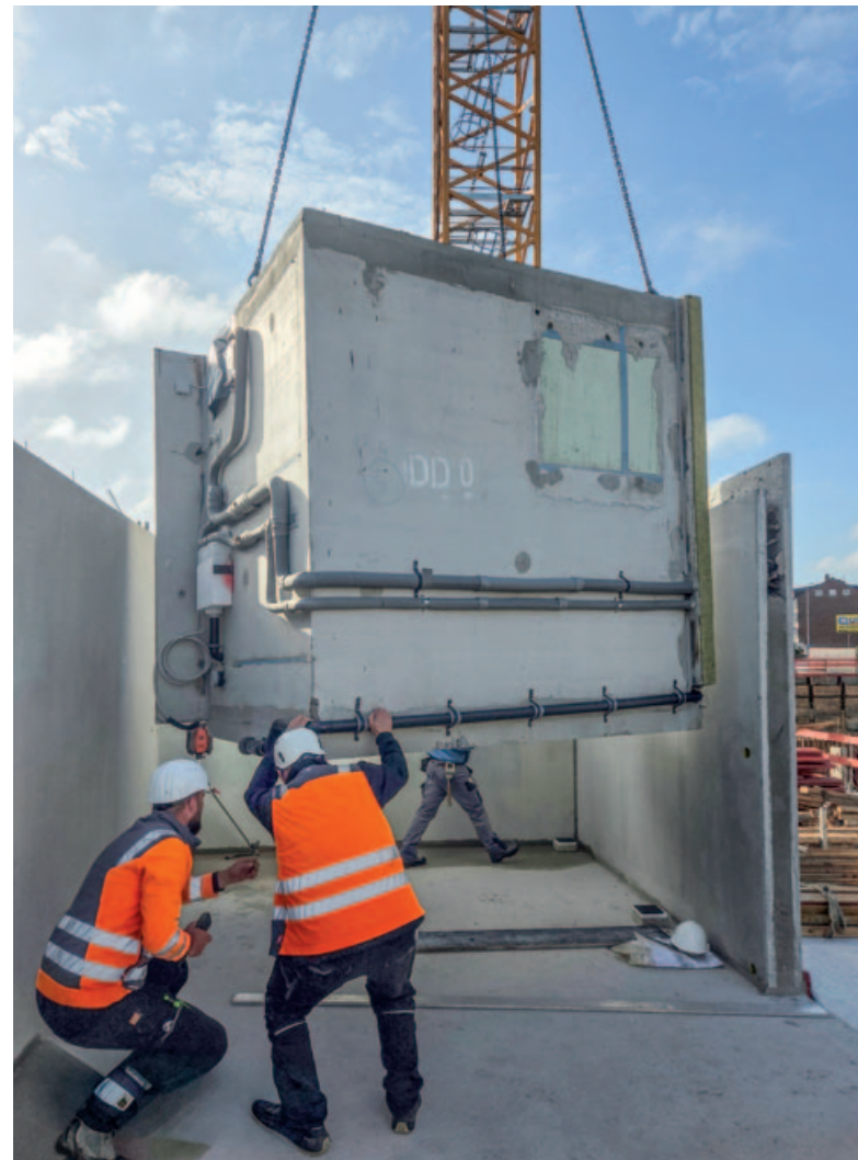
Optimierung des Bauablaufs: Auch die Nasszellen sind vorgefertigt
