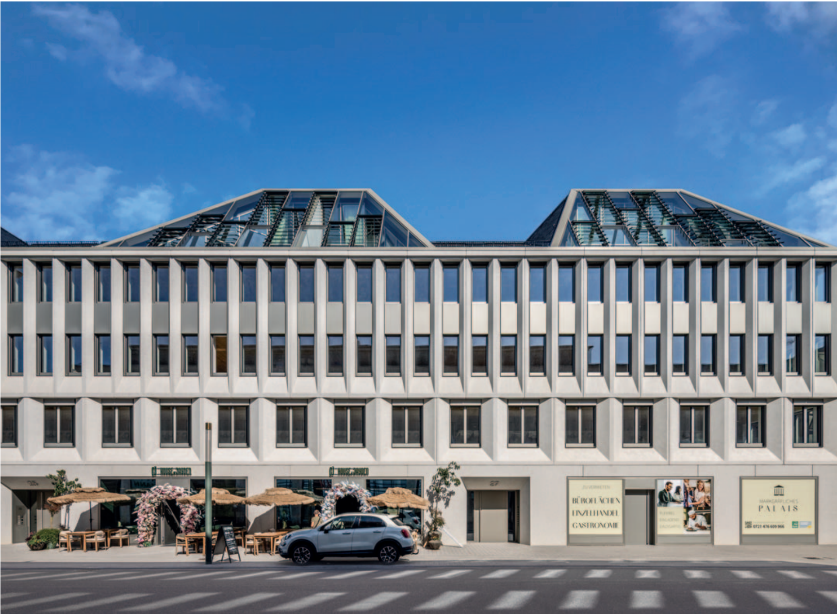
Die vertikale Anordnung und ein ruhiges Raster der Öffnungen interpretieren die historische Formsprache neu. Die feine Gliederung in Sockelzone und Obergeschoss prägen dabei die Fassade.
